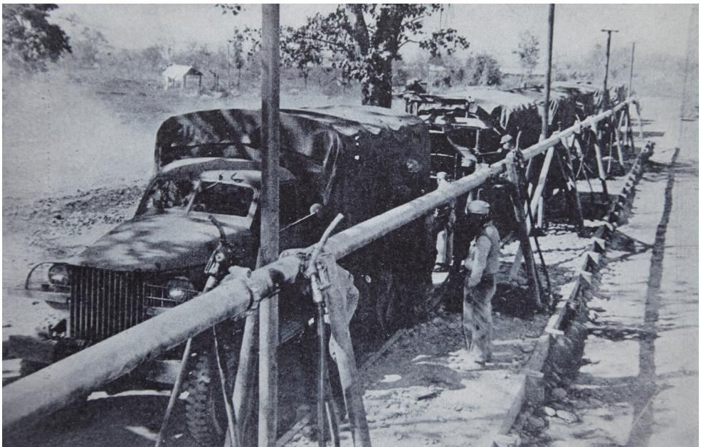
由印度加尔各答经过阿萨密至缅北、再至中国昆明的中印油管，于1944年底建成。该油管口径6寸，绵延千里。从此飞机用油可不靠“驼峰航线”飞机运送。图为缅甸至中国的运输队第一次使用该油管。战后此油管即被废弃。
